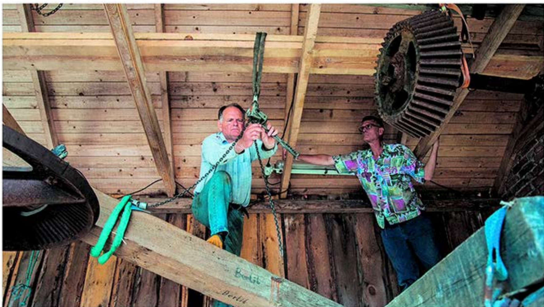
Intresset och engagemanget för Hillefors grynkvärv har ökat. Så här såg det ut när Hans Wessman och Ingmar Rahm bytte bjälkar i turbinhuset förra året.
