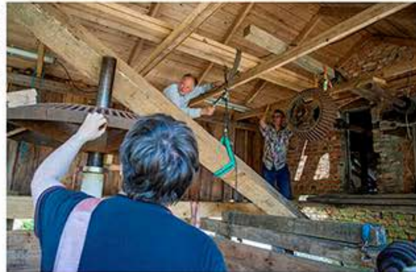
Renoveringen är både tidskrävande och dyr, men medlemmarna i Hillefors Grynkvarns Museiförening jobbar tålmodigt vidare. Här byter Karl Eriksson, Hans Wessman och Ingemar Rahm ut bjälkar i turbinhuset.
